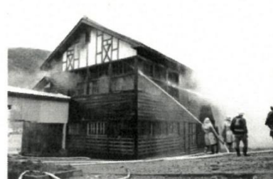
S53.6.4 旧大宮中学校火災 (焼損面積1,753㎡)
