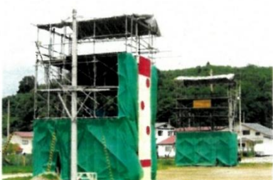
H6.10.31 救助訓練棟 (パイプ造) 2棟完成
