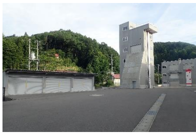
R2. 12. 28 消防本部訓練塔及び一般車両車庫が竣工
