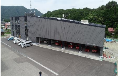
R1. 12. 4 消防本部庁及び車庫が竣工
