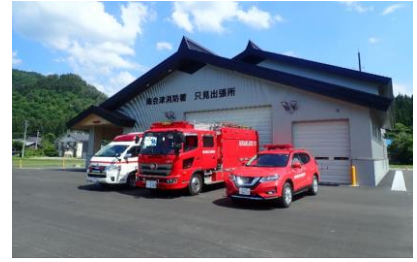
R6. 6. 30 只見出張所新庁舎が竣工
