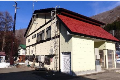
R5. 3. 31 檜枝岐分遣所増改築工事竣工
